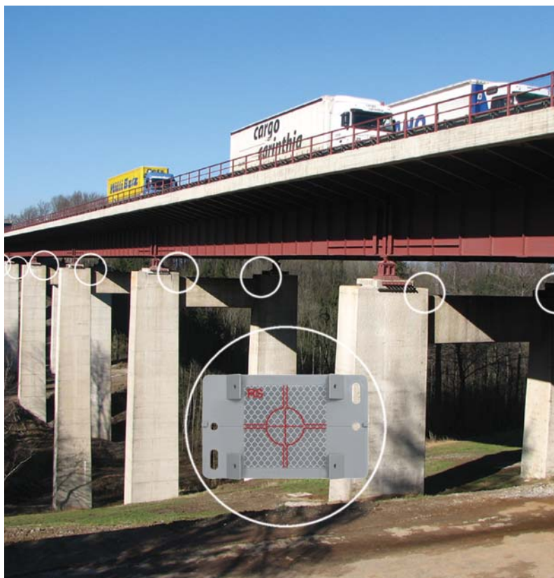
Osservazione del ponte "Loitalbrücke" con RSAKZ6
